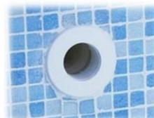
**Bouchon d'hivernage piscine :** Dans le cas d'un hivernage passif (total), Ils se positionnent dans les prises balai et les buses de refoulement afin de boucher les canalisations pour éviter que le gel ne se forme pas dans les canalisations.
